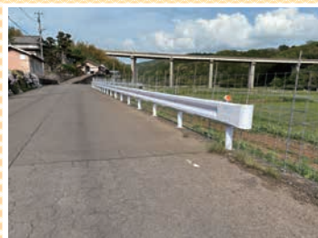
転落防止柵の設置
