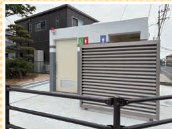
公園トイレ整備
