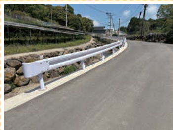
転落防止柵の設置
