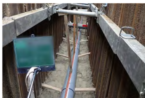
污水管布設状況
