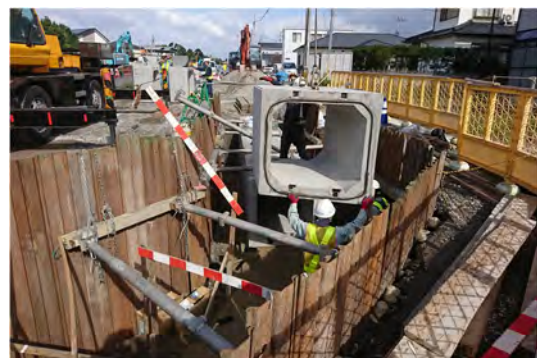
雨水ボックスカルバート布設状況
