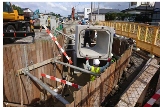
雨水ボックスカルバート布設状況
