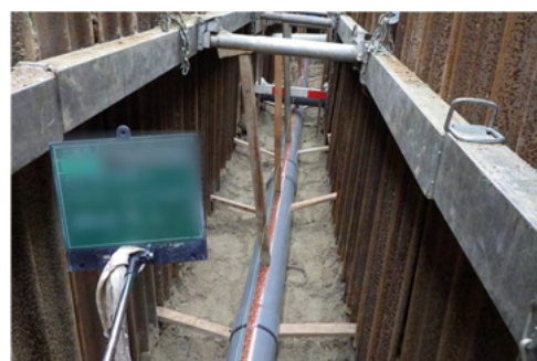
污水管布設状況
