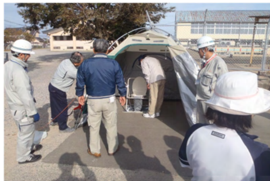
マンホールトイレ（郡中学校）
