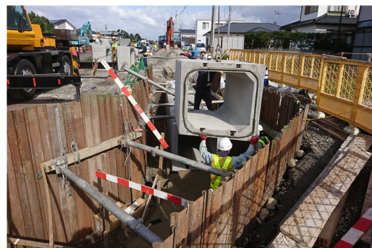
雨水ボックスカルバート布設状況
