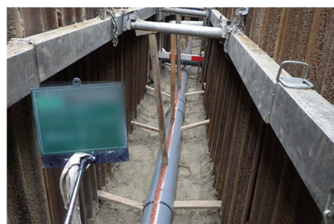
污水管布設状況
