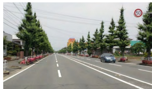
杭出津松原線
