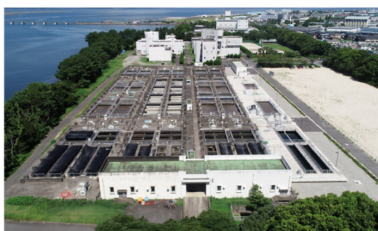
大村浄水管理センター
