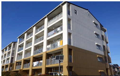
市営住宅（竹松アパート）
