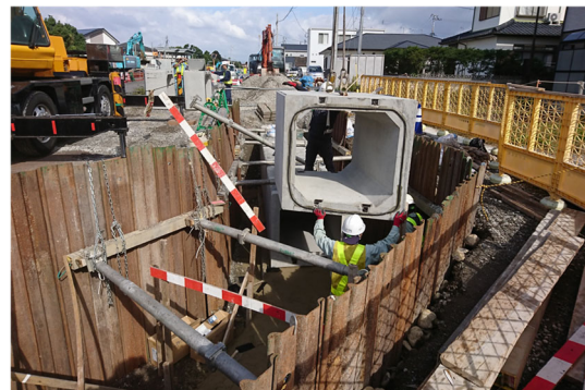
雨水ボックスカルバート布設状況
