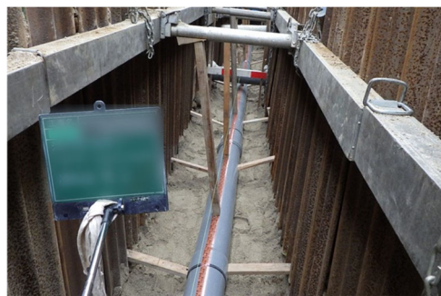
污水管布設状況
