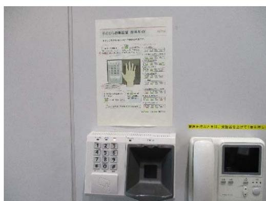
図 6-27 ICカードや手のひら認証による入退室管理の例
