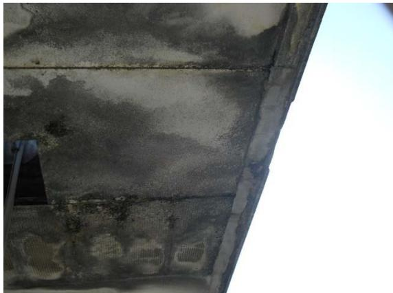
図 2-4 庇先端のモルタル剥離（上下水道局）
