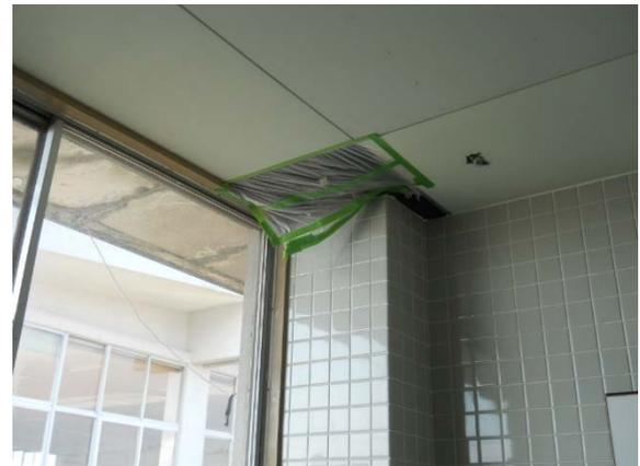
図 2-5 雨漏り（上下水道局）
