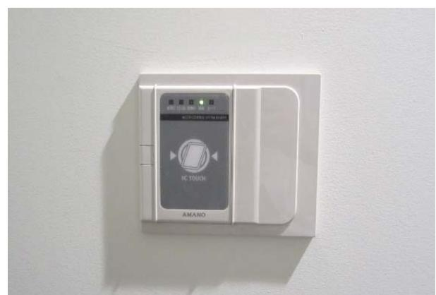
図 6-14 ICカードによる入退室管理の例
