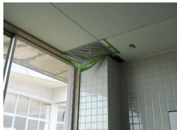
図 2-5 雨漏り（上下水道局）
