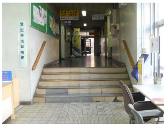
図 2-6 本館と別館との通路の階段（本館）
