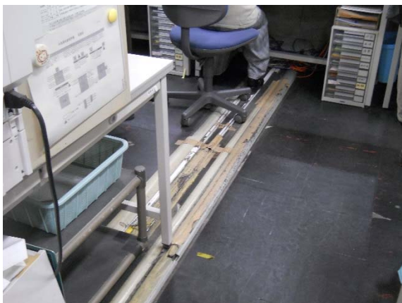
図 2-12 床への配線（本館）
