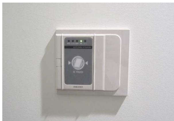
図 6-14 ICカードによる入退室管理の例
