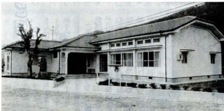
◀菅瀬地区コミュニティセンターが完成（田下町） 白を基調とした 210㎡の木造平屋建て。大会議室のほか和室、調理室などがあり、菅瀬地区の文化の中心として活用が期待されています。総事業費1650万円。
