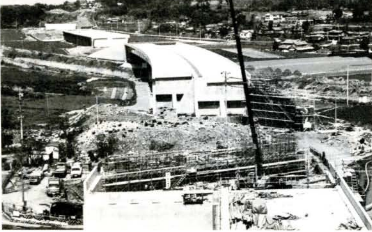
64年度開通を目指している九州横断自動車道整備（坂口付近）
