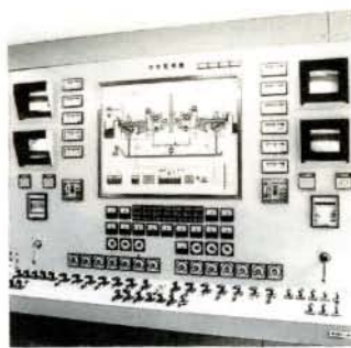
各機器の操作をする中央制御室
