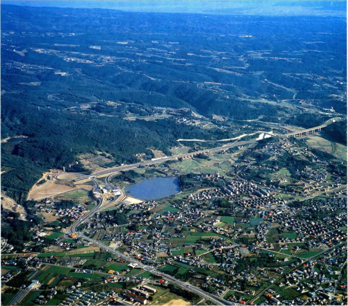
(長崎自動車道大村インターチェンジ付近)
