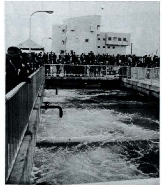
エアレーションタンク
