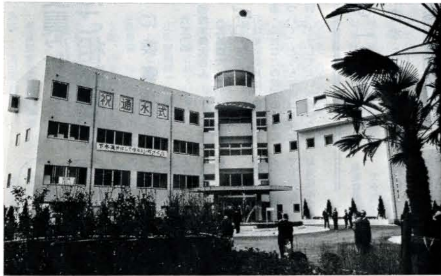
浄水管理センター
