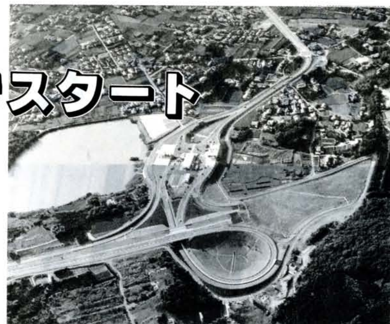
(九州横断自動車道・大村インターチェンジ付近)
