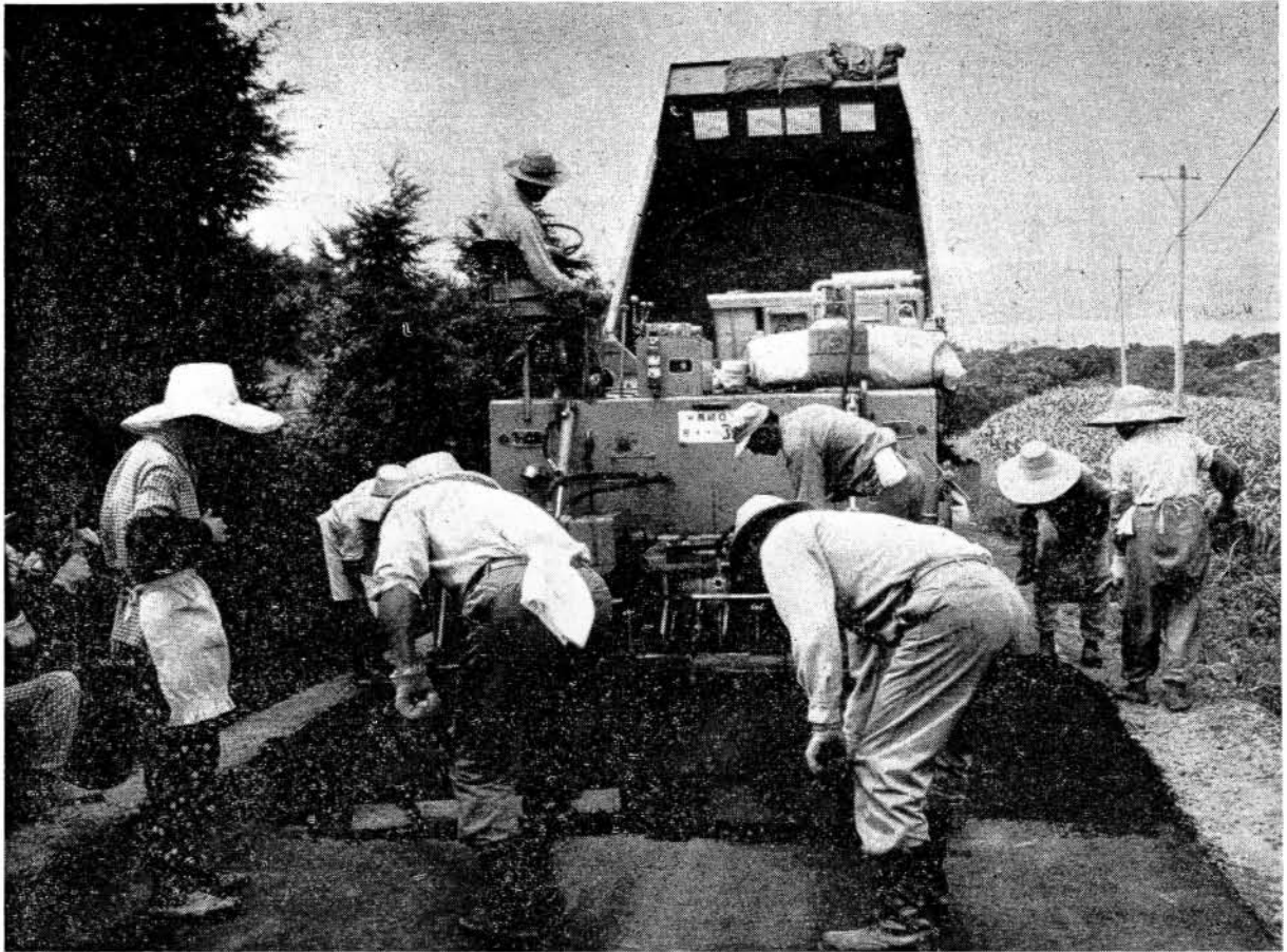
上小路-大多武線市道舗装工事
