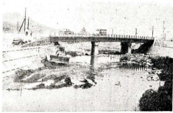
成田橋の延長工事。昨年十月から着工されたが、このほどできあがりしました。この橋は長さ約二倍の五四・四メートル幅員は八・二メートル有効幅員七・五メートルで、P S コンクリート合成桁を使用しています。(建設課)
