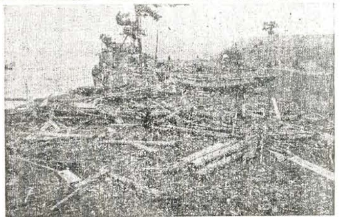
海岸に打上げられた漁船と海水浴場施設の残がい(松原鹿の島附近)
