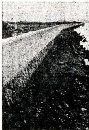
竹松海岸堤防 = 高潮を防ぐため県では竹松海岸に堤防を構築することとなり、昨年度から工事を始め、35年度で延長602メートル本年度644メートル計1,246メートル高さ3.5メートルの堤防が完成しました。(写真上)
