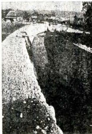
市道片町線の舗装は昨年度片町稲荷神社付近を一六四メートル幅七・五メートル舗装(工費一八〇万円)引きつづき本小路公園前国道まで五〇〇メートル、幅七・五メートルを八月着工、十一月末完成しました。(工費六九〇万円)(写真右)上は本小路、下は片町付近)藤の川排水路は昨年度延長一五二メートルを実施、本年度引きつづき八月一日から工事を続行、延長一八一メートル、高さ三・二メートル、幅四メートルで近く完成します。工費は三三〇万円(写真左)
