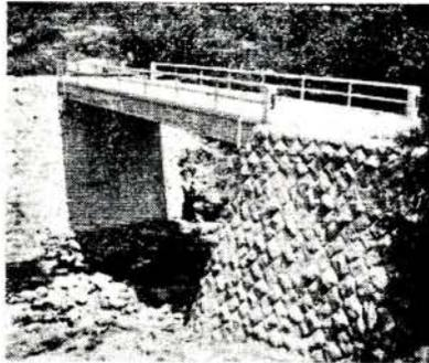
■南川内二号橋(7月)——南川内部落の入口にあるこの橋は木橋から鉄筋コンクリートの永久橋となった。総工費=456万円、長さ=15.07メートル、巾=4.47メートル
