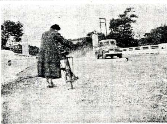
本年3月着工、12月1日竣工した。延長23米20総巾員12米のコンクリート造で総工費772万餘圓である
