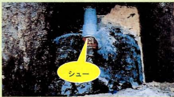
【配水管漏水状況】
