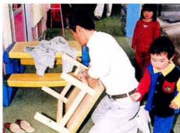
大村木工業協同組合は、良い戸の日(4月10日)にちなんで、各公立保育所や幼稚園などの建具の補修や調整などを行いました。(4月9日・三城保育所)
