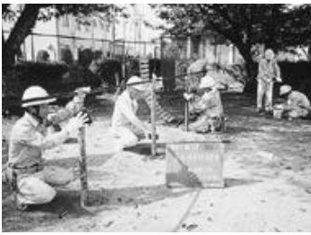
大村技能士会 市内の小中学校や幼稚園・保育所の壊れた遊具などの普請活動。
