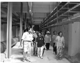
浄水管理センターの施設見学の様子(昨年)
