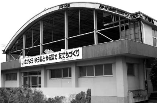
▷壁が崩壊した体育館 (放虎原小)
