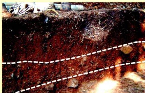
土の堆積のようす。点線ではさまれた土層が大改修の盛土。
