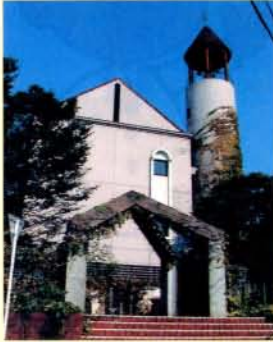
第1回大村市都市景観賞受賞 ■建築部門 向陽高校：カロコンの鐘のある塔と周辺の造形
