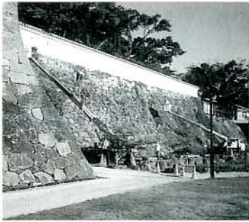
奉仕作業する九電工大村営業所員の皆さん (10/21・大村公園)
