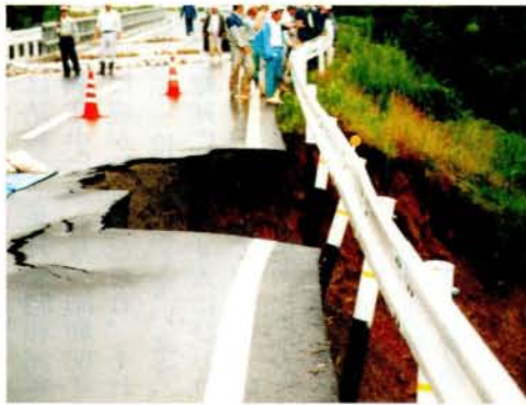
大雨で陥没した「レインボーロード」(7/11)
