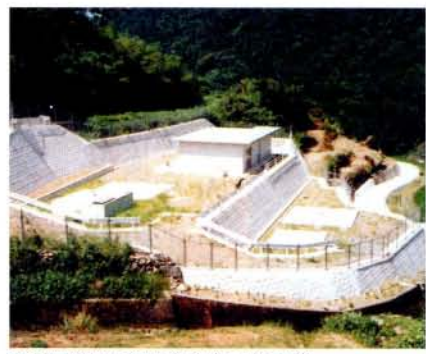
建設が進んでいる久良原浄水場
