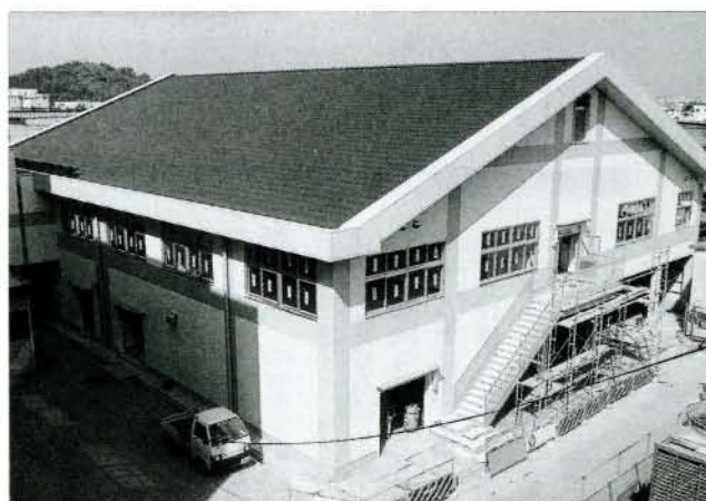
庁舎が手狭になり、増築されている市役所別館
