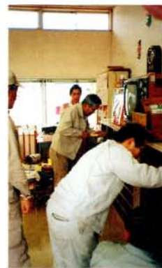
ボランティア活動 大村木工業協同組合(野中秀一代表)は、4月10日の「良い戸の日」に、清和園・各公立幼稚園・保育所の建具の補修・調整の奉仕をしました。
