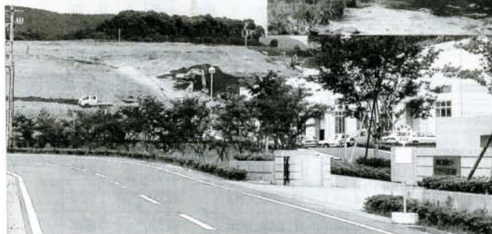
着々と進む大村ハイテクパーク内の造成工事。右は県工業試験場（池田2丁目）
