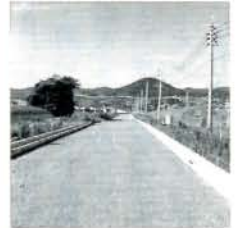
道は、進んで、立って、通っています。工事している杭出津松原線（寿古工区）
