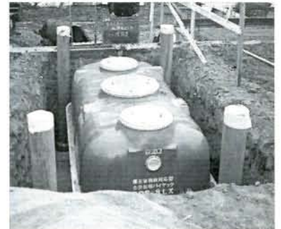
合併処理浄化槽の設置現場
