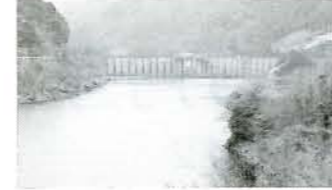
萱瀬ダム・現在拡張工事が進められています
