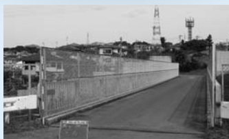
通学道路の整備(落下防止柵)
