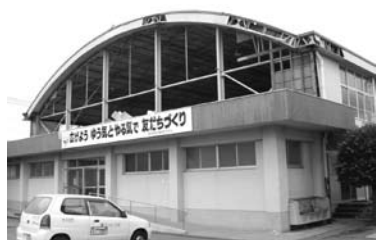
平成18年9月の台風13号により壁が損壊した放虎原小学校の体育館
