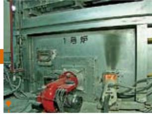
焼却炉に投入したごみを勢よく燃やします。焼却炉内の温度は約900度。高い温度で燃やすことで、ごみのおいをなくします。
