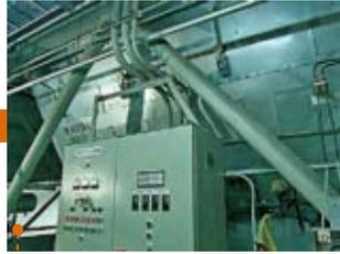
ビニールやプラスチックは、燃やすと有害なガスが出ます。特別な装置を使って有害な成分を取り除き、きれいなガスを排出。
