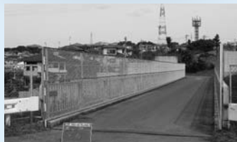
通学道路の整備(落下防止柵)
