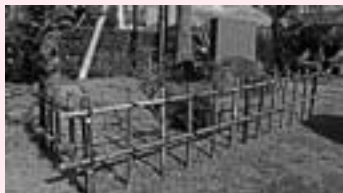
竹松地区町内会長会から、庁舎前広場、市民憲章碑用の竹柵の改修工事を行っていただきました。(平成21年11月28日)
