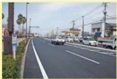
国道34号の拡幅工事完成 3月21日(土)
