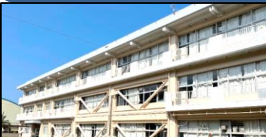
新しく塗り替えられたC棟全景
