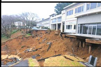
校舎前が大きく崩落した金沢北陵高校
