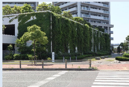
立体駐車場の外壁・屋上の緑化
