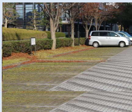
駐車スペースの緑化ブロック舗装
