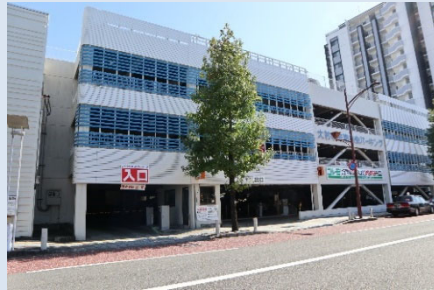
ルーバーによる駐車場開口部の目隠し
