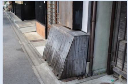
空調室外機を囲った犬矢来
