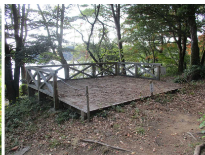
ウッドデッキ
