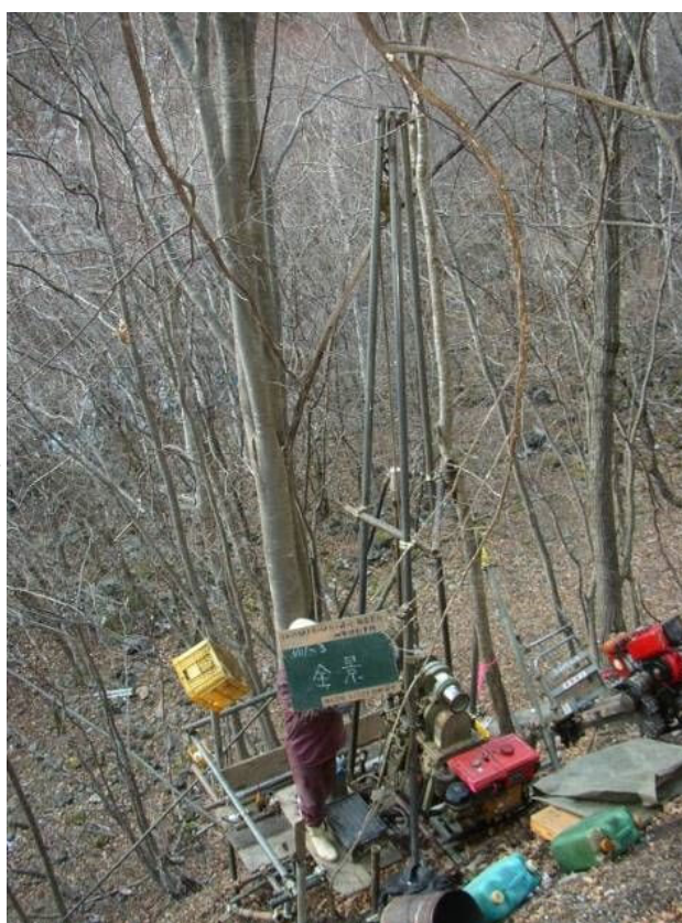
図 2.3.1 ロータリー式ボーリングマシン概念図と掘進状況写真（例）
