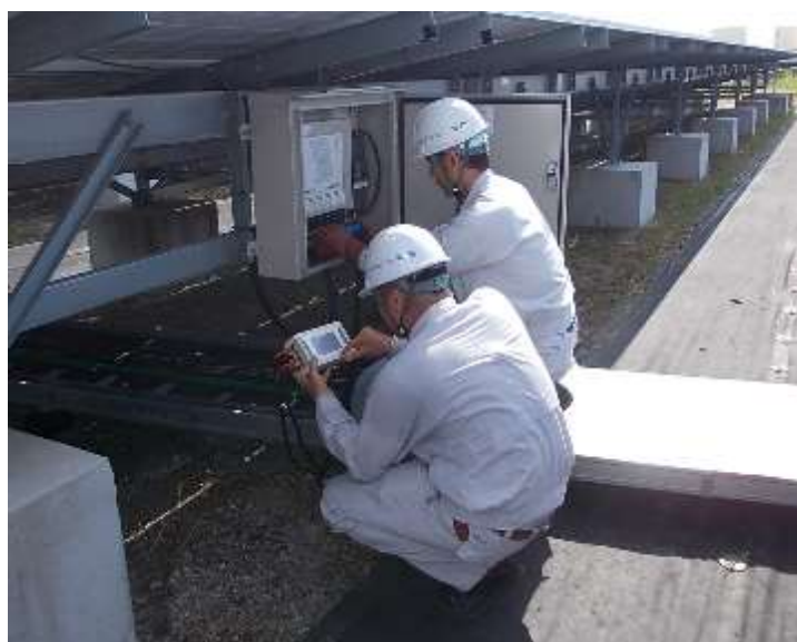
I-V 検査実施時の参考写真（発生現場での実施例）
