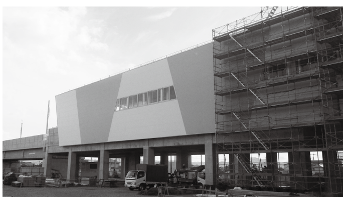
令和4年秋ごろの九州新幹線西九州ルート（長崎～武雄温泉）開業に向けて、新大村駅（仮称）周辺では駅舎などの建設工事が進んでいます。（写真は令和2年9月25日撮影）。
