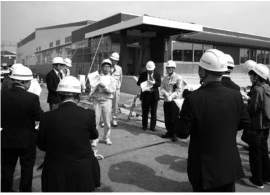
小学校給食センター工事の現地調査を行う委員会
