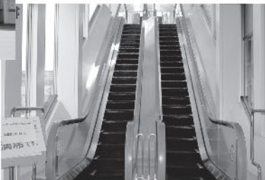
新設されたエスカレーター：右
