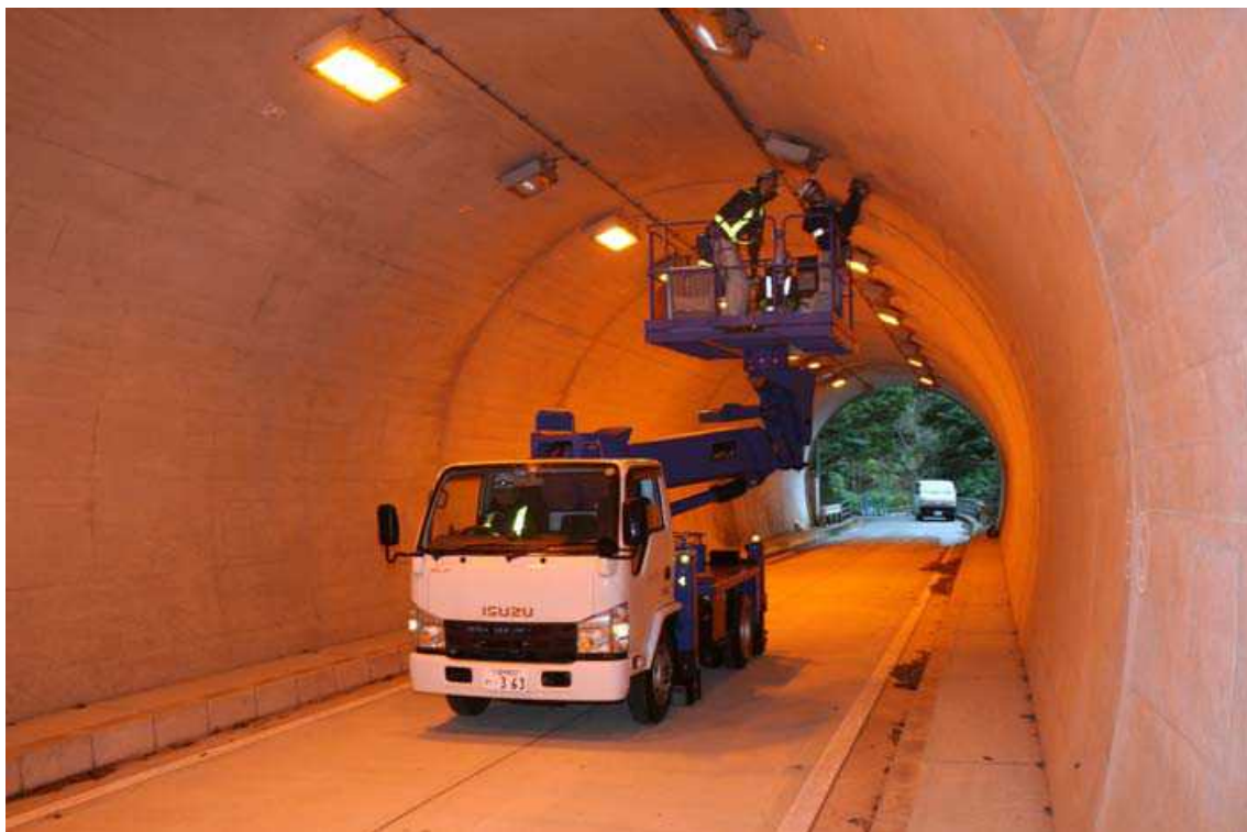
高所作業車による点検
