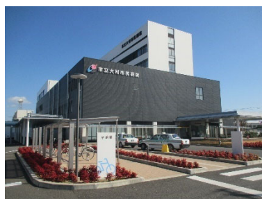
市立大村市民病院 駐輪場
