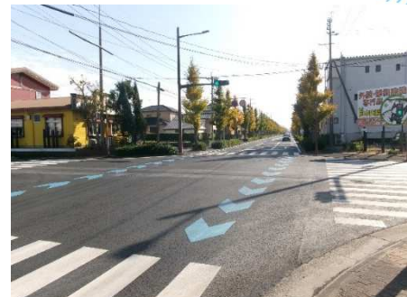
矢羽根型路面標示整備状況(市道杭出津松原線)
