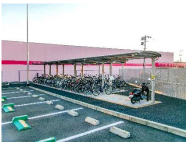
大村車両基地駅前駐輪場
